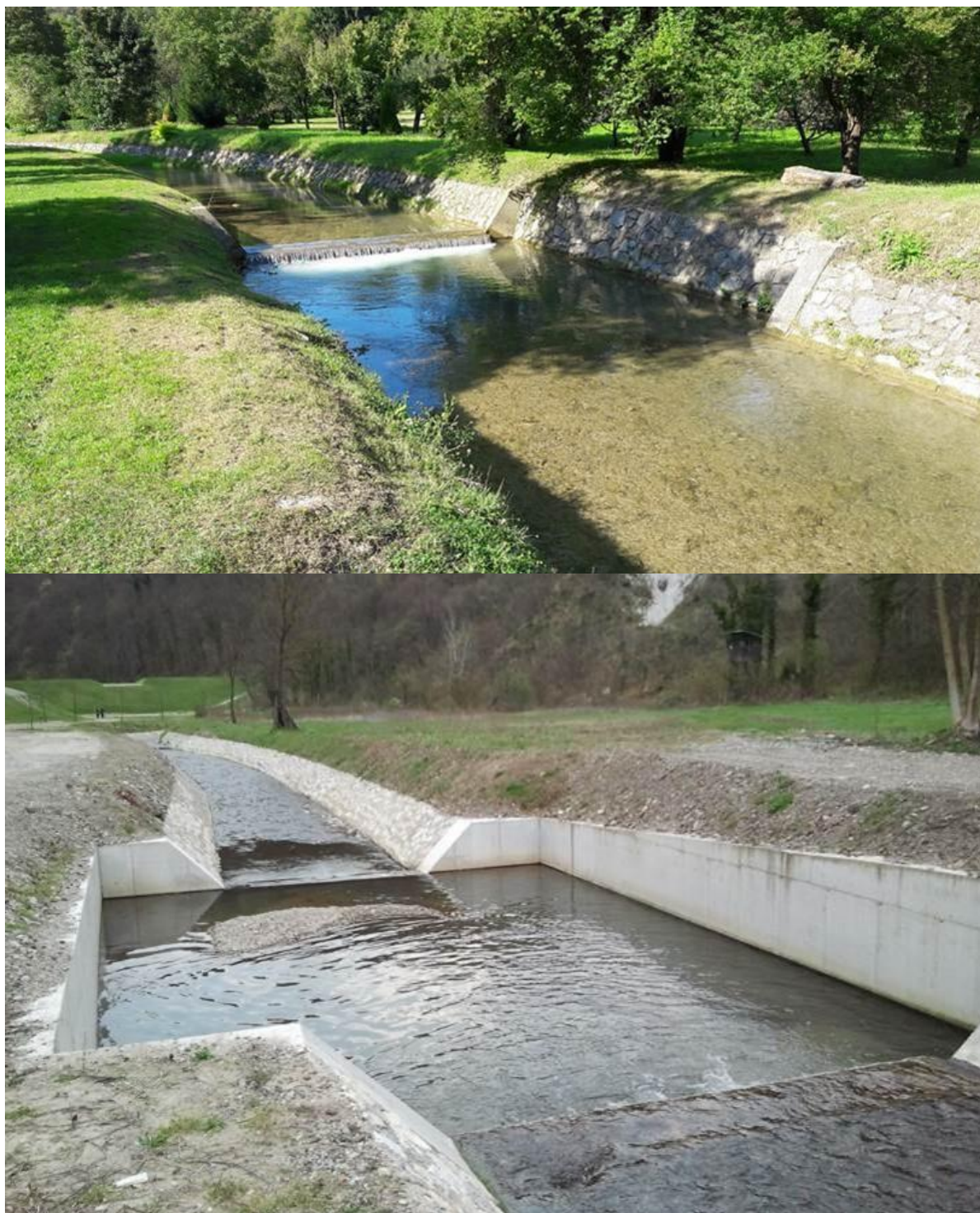
Slika 20. Prikaz planiranih ukopanih slapišta (bučnica) kako bi se lakše predočila planirana građevina
