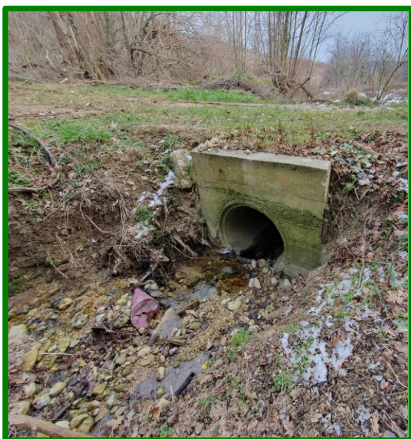
Slika 9. Uljev propusta 4 (Izvor: Tau projekt d.o.o.)
