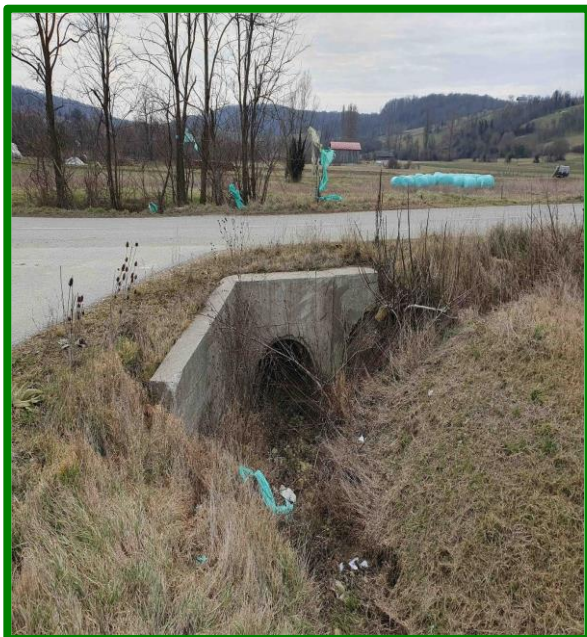
Slika 15. Uljev propusta 1 (Izvor: Tau projekt d.o.o.)
