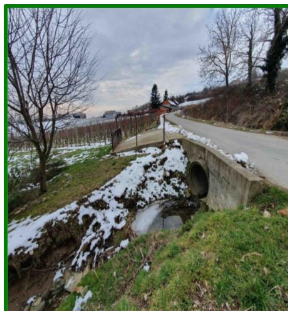
Slika 6. Cijevni propust 5 – izljev propusta (Izvor: Tau projekt d.o.o.)
