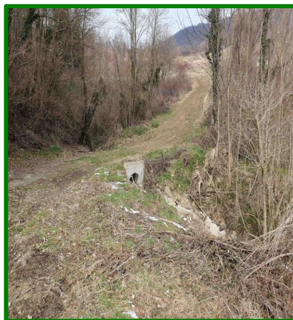
Slika 10. Izljev propusta 4 (Izvor: Tau projekt d.o.o.)
