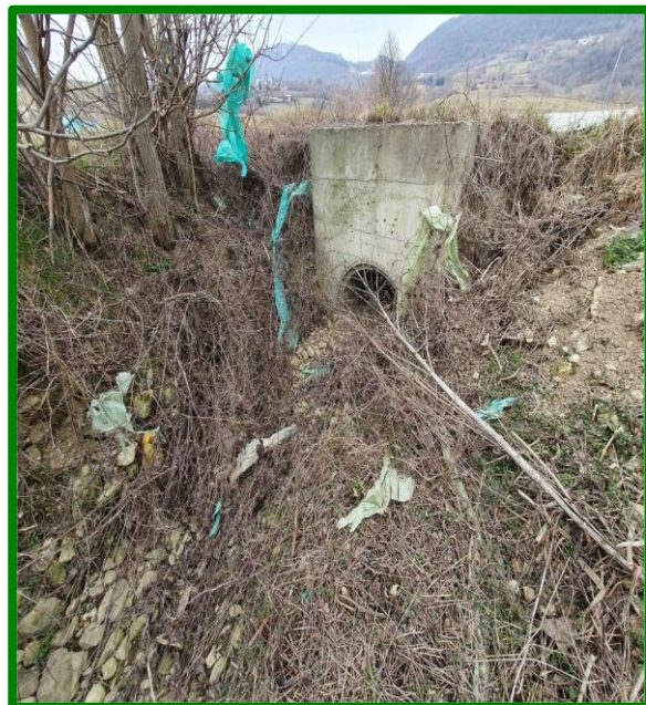
Slika 16. Izljev propusta 1 (Izvor: Tau projekt d.o.o.)
