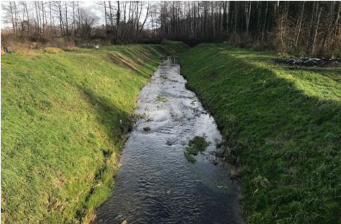
Slika 1.9 Lokacija zahvata – regulirana dionica vodotoka – dionica 3
