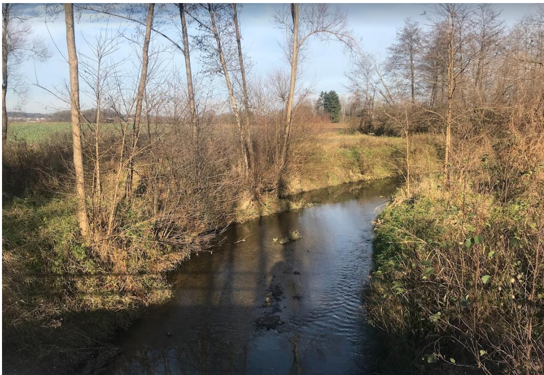
Slika 1.5 Lokacija zahvata – neodržavani vodotok dionica 1
