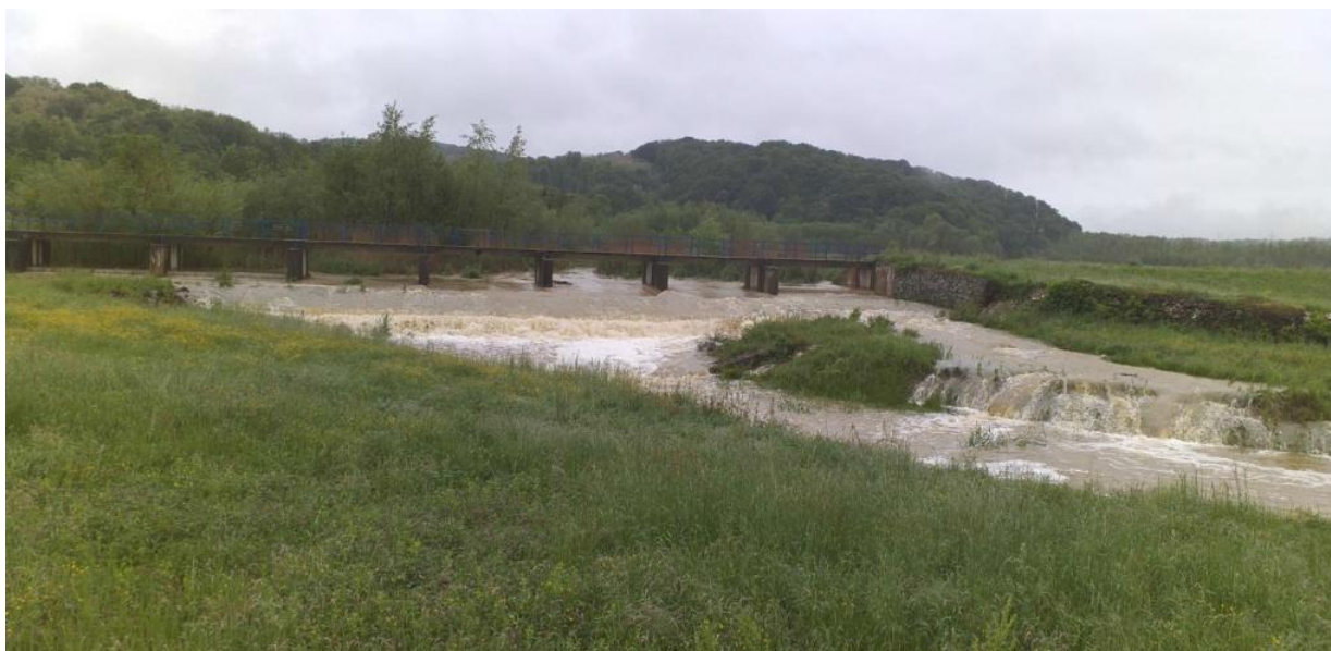
Sl. 1.2.14 Aktivacija bočnog preljeva
