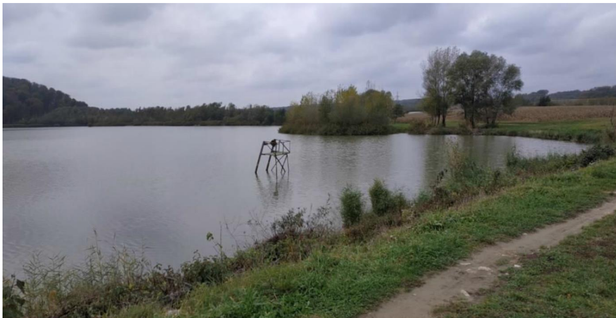
Sl. 1.2.8 Ulazna građevina temeljnog ispusta
