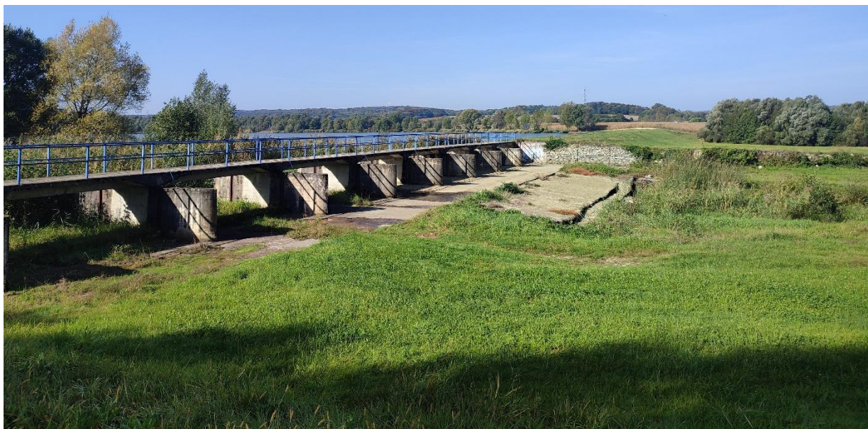
Sl. 1.2.13 Trenutno stanje bočnog preljeva (listopad 2023)
