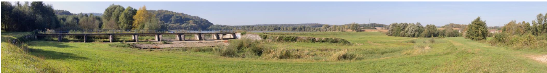
Sl. 3.12.4: Točka 1: Panoramska snimka postojećeg bočnog preljeva i brane, pogled na jugozapad
