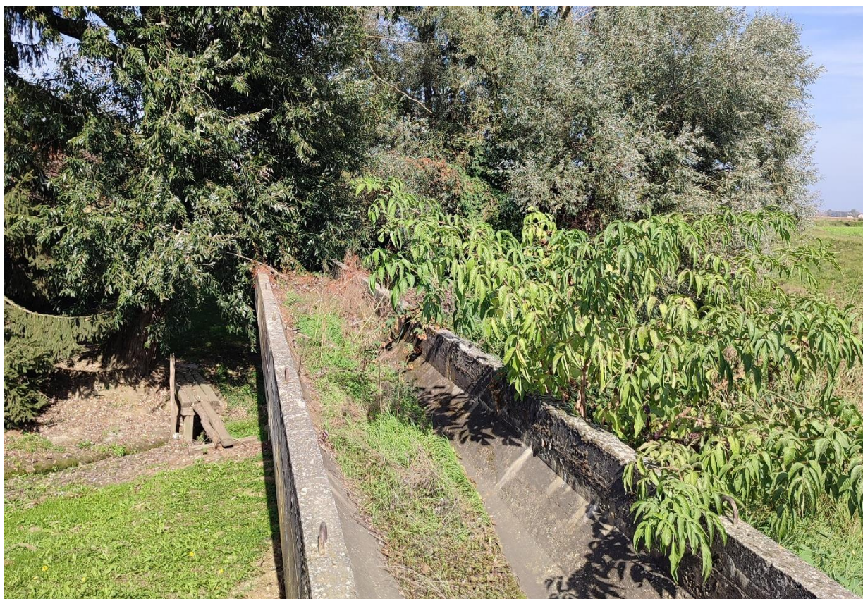
Sl. 1.2.11 Trenutno stanje odvodnog kanala za ribnjake (listopad 2023)
