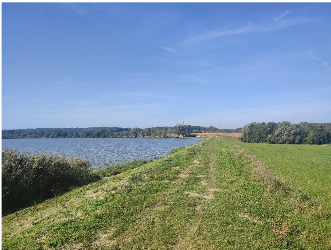
Sl. 1.2.7 Brana na akumulaciji Rasinja
